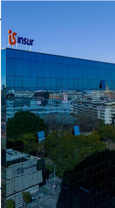
EDIFICIO INSUR – SEVILLA
